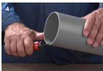
4 Verwijder scherpe kantjes binnenzijde
