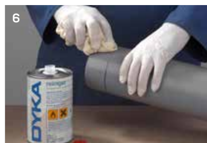
6 Buiseinde reinigen met DYKA reiniger
