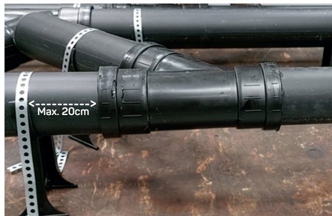
Figuur 2: Beugel en fixeer de leidingdelen op maximaal 20cm vanaf de verbinding.
