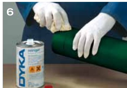
Buiseinde reinigen met DYKA reiniger
