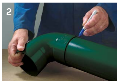
2 Zaznacz głębokość osadzenia
