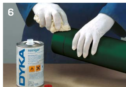
6 Oczyść koniec rury środkiem czyszczącym Dyka
