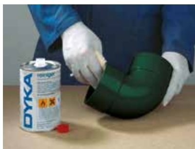
Binnenkant hulpstuk reinigen
