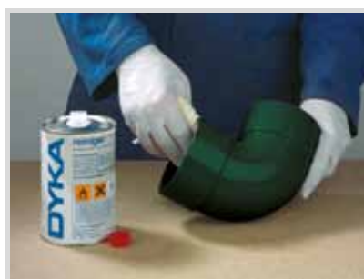
Binnenkant moffen reinigen
